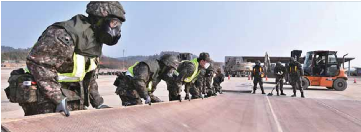
12일 공군3훈련비행단이 전개한 26-1차 전투태세훈련에서 공병대대 장병들이 활주로 피해복구 훈련을 하고 있다. 사진 제공=전미화 상사
