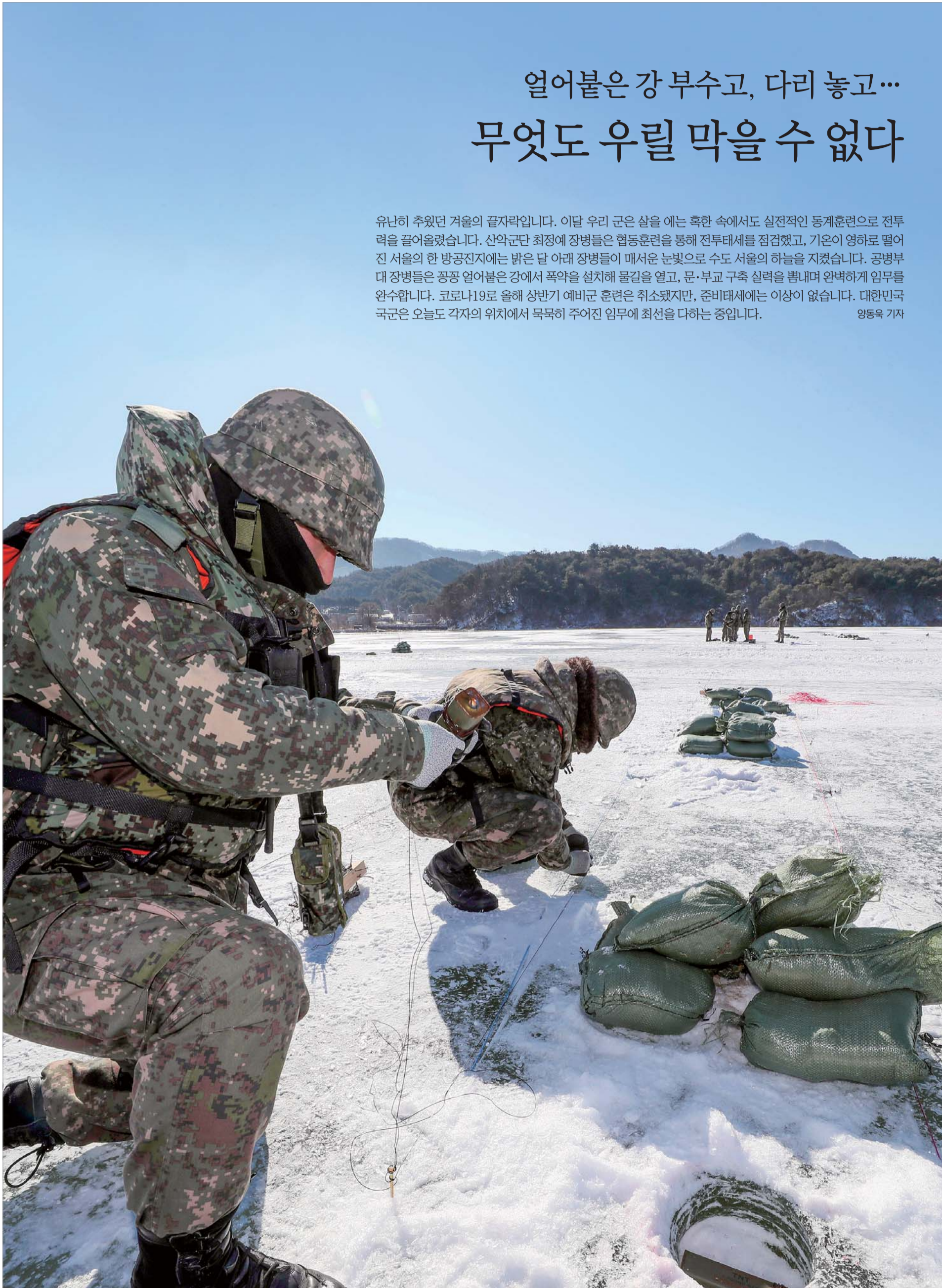
물길을 만든다 육군5공병여단 장병들이 강원도 철원군 도하훈련장에서 실시한 흑한기 파방훈련에서 얼어붙은 강에 폭약을 매설하고 있다. 한재호 기자
