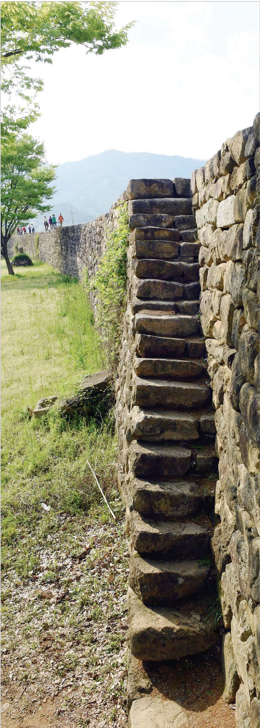
동·서·남문의 주 계단 외에 성 안에서 성벽으로 오르는 폭이 좁은 계단이 16개 있다. 유사시 성 안의 백성들이 신속히 성벽 위에 올라 방어하기 위한 시설로 볼 수 있다.
